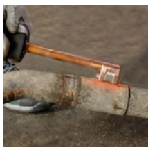
Sbloccaggio dei sistemi di scarico
