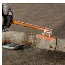
Sbloccaggio dei sistemi di scarico
