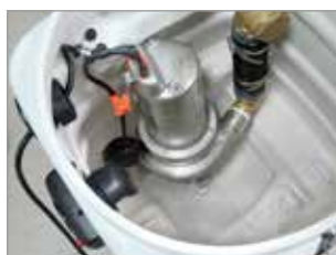
POMPA IMMERSA IN ACCIAIO
